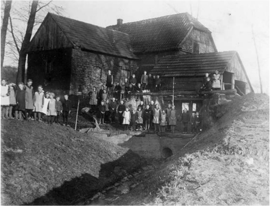
Die Baseler Schulkinder an der alten Wassermühle Schulze Bomke
